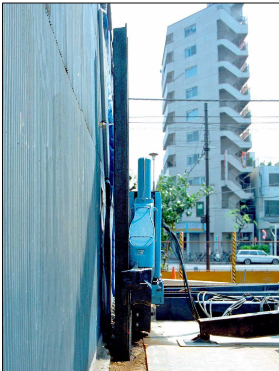
硬質地盤対応ゼロパイラーによる施工イメージ図
