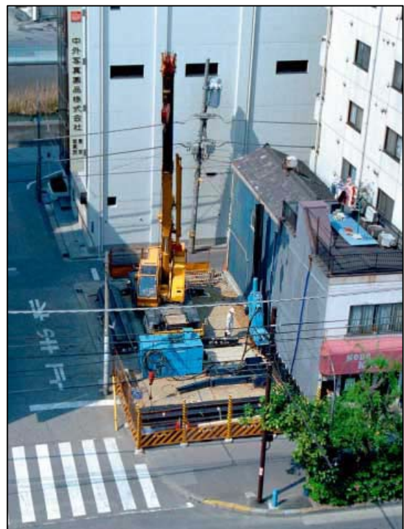
硬質地盤対応ゼロパイラーによる施工イメージ図
