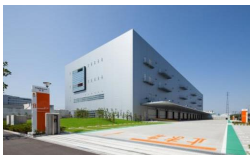
ロジスクエア草加 2013 年 6 月竣工
