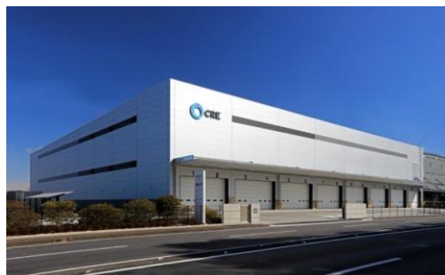
6 ロジスクエア久喜Ⅱ 2017 年 2 月竣工
