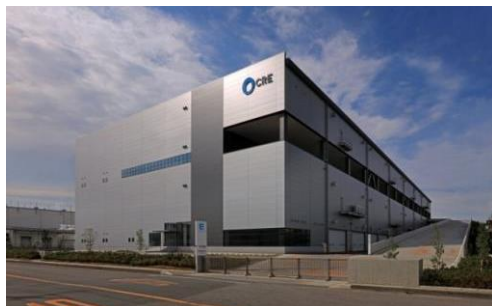
4 ロジスクエア久喜 2016 年 6 月竣工
