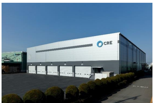
12 ロジスクエア川越 2018 年 2 月竣工
