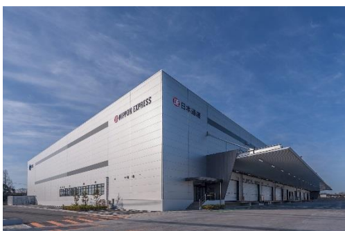
11 ロジスクエア鳥栖 2018 年 2 月竣工
