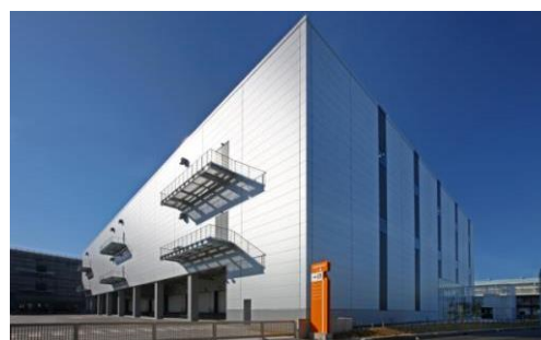
ロジスクエア八潮 2014 年 1 月竣工
