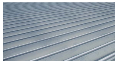
遮熱塗料を塗布した屋根
