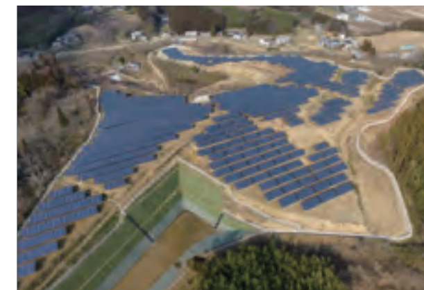
宮城登米太陽光発電所(宮城県)
