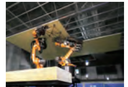
天井を施工する「ROBO-BUDDY」
