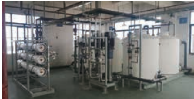
東陽精密機器の逆浸透膜浄水装置
