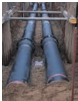
水道用ダクタイル鉄管
