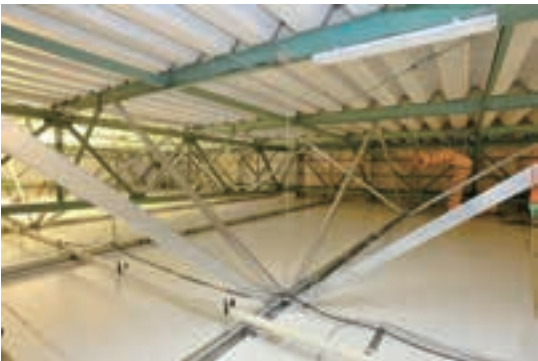
東日本大震災後に開発された耐震天井NEQRES® (ネクレス)。2016年の熊本地震では一枚も落ちませんでした。
