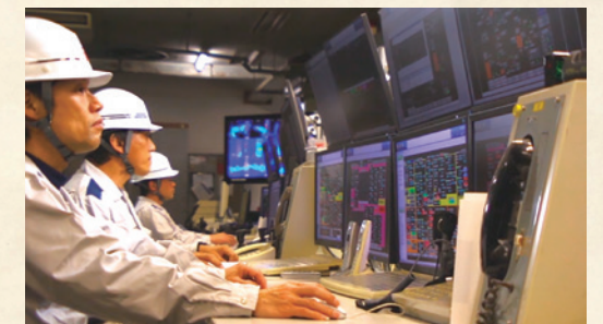
安全・安心な操業を支える計器室
