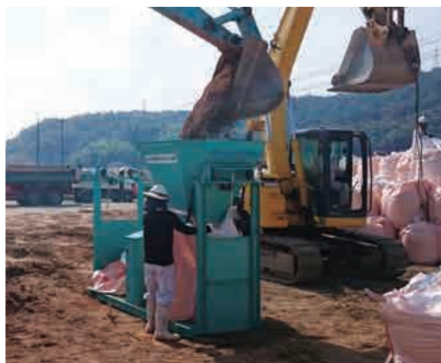
西日本豪雨災害復旧工事（砂川地区）
