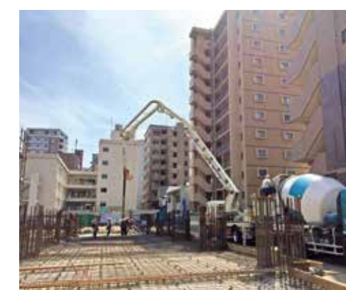
コンクリートポンプ車による圧送イメージ
