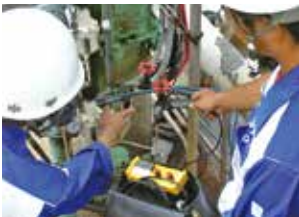
王子製紙御春日井工場での省エネパトロール エア漏れによる無駄がないかの確認
