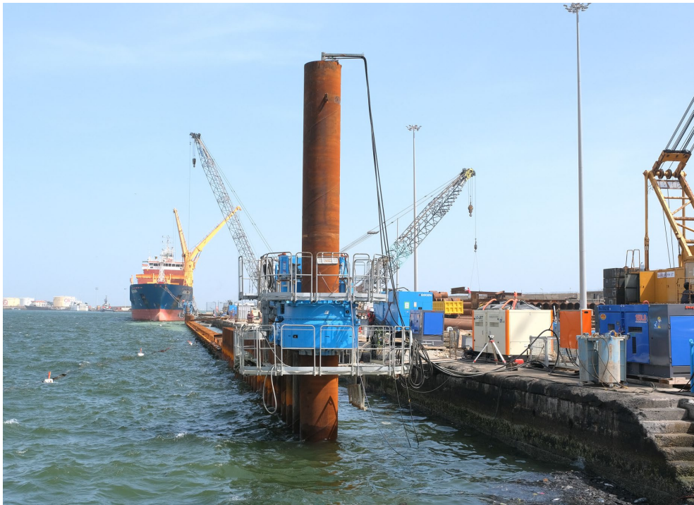
セネガル ダカール港での埠頭改修工事
