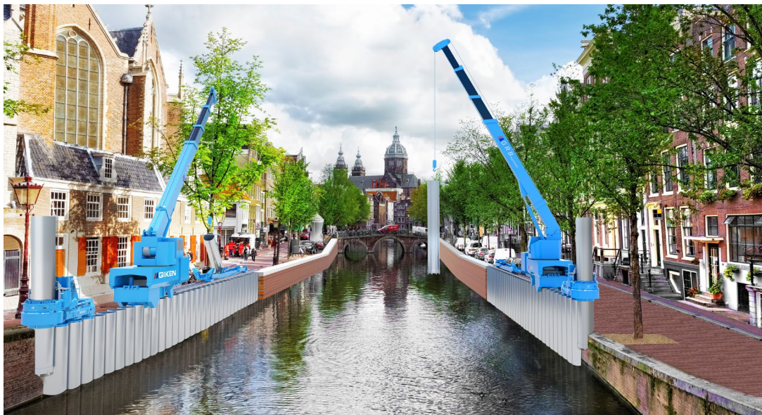
「ジャイロプレス工法」と「GRBシステム」による施工イメージ図
