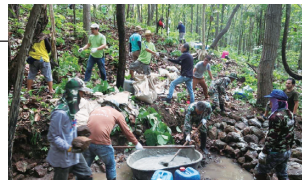
水堰止め堀設置の様子
