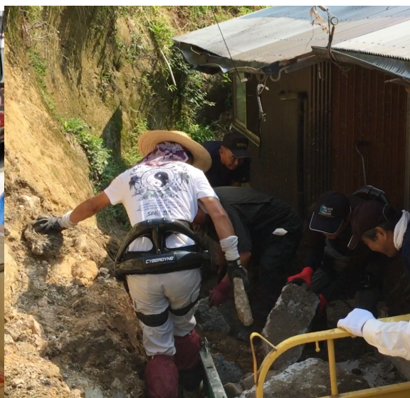
2020年8月21日(瓦礫撤去作業)
