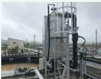
噴流式酸素供給装置(フォームジェット)により、酸素ガスをファインバブル化することで、高効率酸素供給が可能となる装置です。排水中にファインバブルを溶解させることにより、さまざまな効果を得ることが期待されます。
