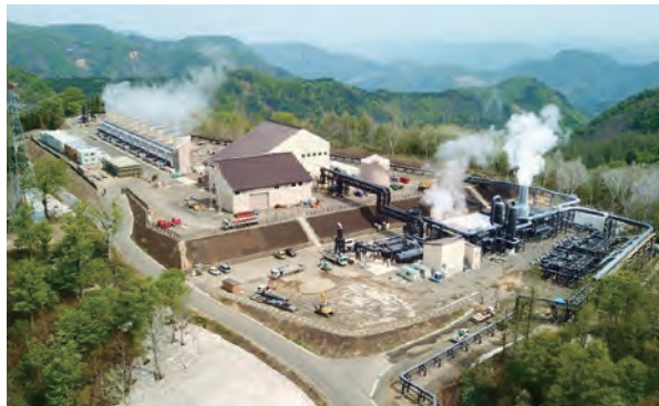
山葵沢地熱発電所(全景)
