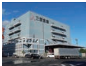
横浜支店大黒C号倉庫
