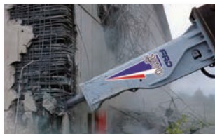
岩石の小割りやコンクリートの破砕に使用されています。
