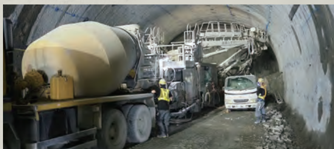
ミキサー車と吹付け作業
