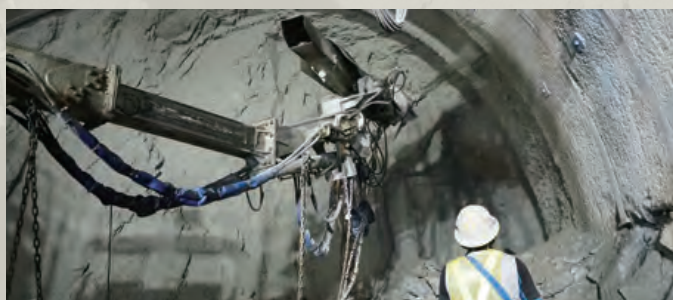
吹付けコンクリート施工状況
