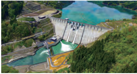
津軽ダム （青森県） 2016年 当社が施工した直上流60mに位置する目屋ダムの再開発に位置付けられた多目的ダムで、打設工期の短縮が可能な「巡航RCD工法」を採用 土木学会デザイン賞2018最優秀賞、2017年度土木学会技術賞
