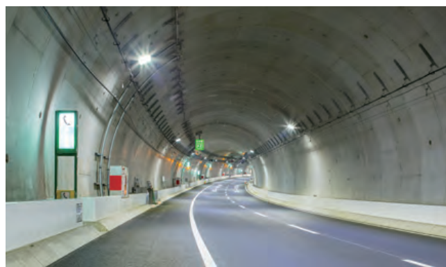
横浜北西線 青葉行き(内廻り)トンネル
