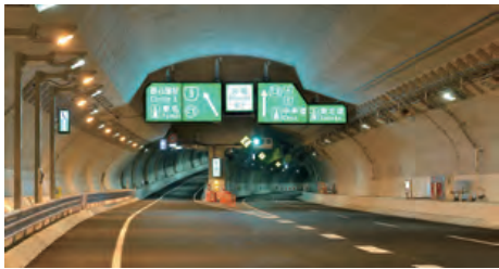
首都高速中央環状品川線大橋連結路 （東京都） 2014年 並行する2本のシールドトンネルを開削せずに切り開く世界初の工法「セグメントによる非開削切開き」工法を採用 2014年度土木学会技術賞
