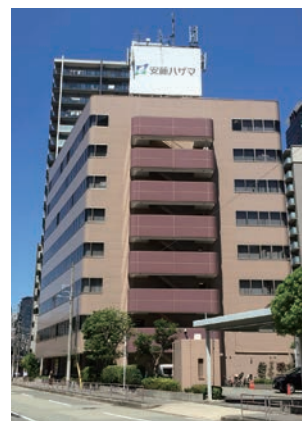
脱炭素ビル(大阪安藤ハザマビル)
