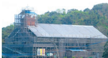
黒島天主堂外観（施工中）
