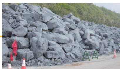
着底マウンド/人工地盤材 アッシュクリート破砕材設置状況
