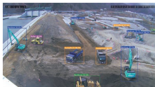
システム画面 (AIによるダンプおよび建機の識別)
