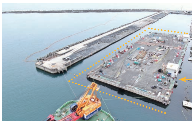
着底マウンド/人工地盤材 アッシュクリート破砕材設置状況
