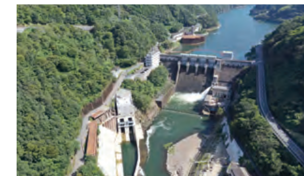
トンネル洪水吐(写真左)を備えた鹿野川ダム(愛媛県大洲市)
