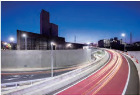
市街地における急勾配・急曲線・小土被りの大断面シールド トンネルの建設(横浜北線馬場出入口)
