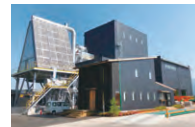
信州ウッドパワー(長野県東御市)
