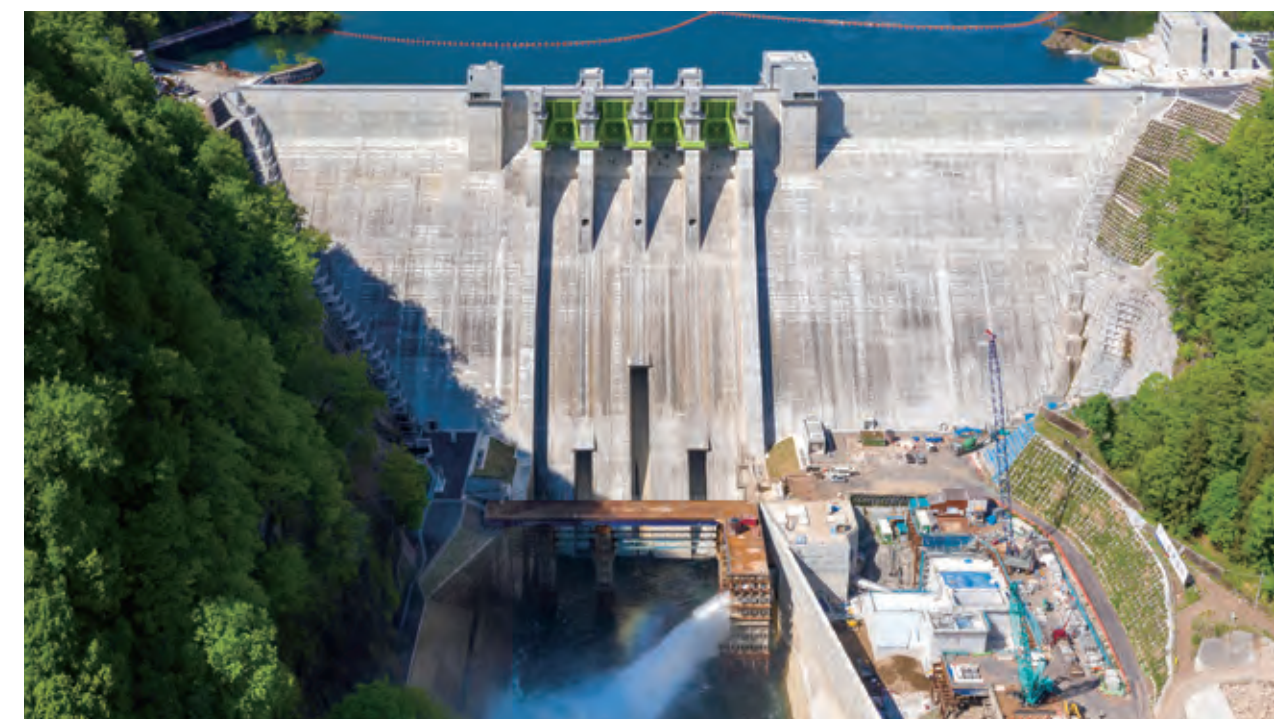
堤高116mの重力式コンクリートダム、ハツ場ダム(群馬県吾妻郡)
