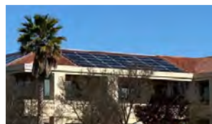
建設中の太陽光発電設備(米国)
