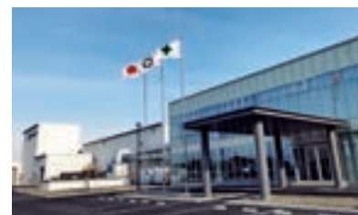
千葉県船橋市 新段ボール工場
