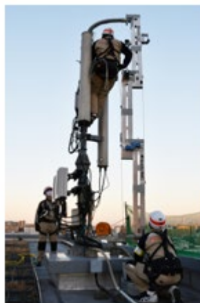
■施工イメージ写真
