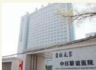
ICUや救命救急の廊下にアイカウイルテクトとセラールウイルテクトを納入することが決定した「吉林大学中日聯誼病院(长春市)」
