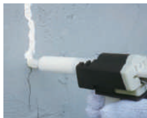
ガンタイプのため、コンクリートのひび割れを素早く容易に補修できる
