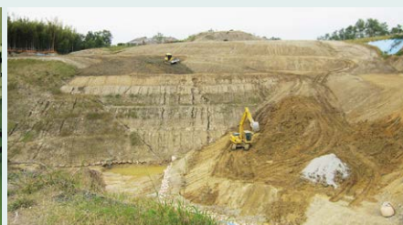
フェロシルト回収工事の様子
