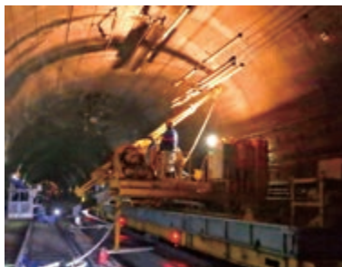
東海道新幹線大規模改修工事
