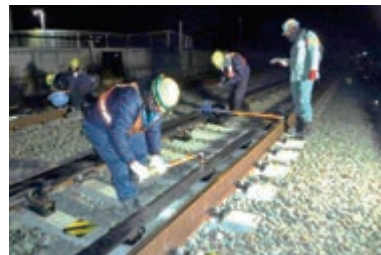
脱線防止ガード敷設
