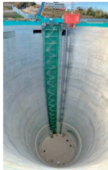
坂下非常口：立坑本体の完成
