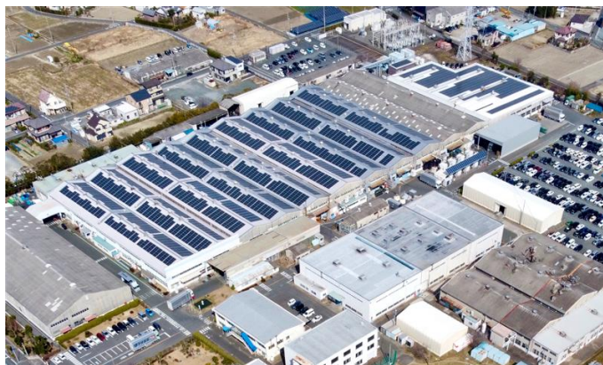
（THK リズム株式会社浜松工場 静岡県浜松市 発電容量：1,829.52kW）
