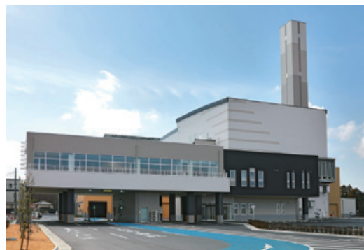
霞台厚生施設組合新広域ごみ処理施設 （愛称：霞台クリーンセンターみらい）（茨城県）
