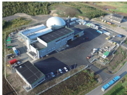
バイオガスプラント（スウェーデン）
