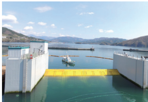
岩手県（細浦漁港）向け海底設置型フラップゲート式水門
