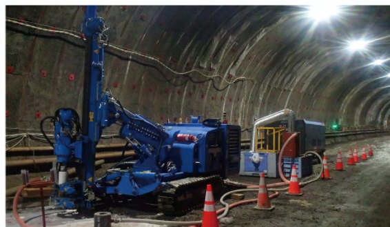
トンネル内での試験施工状況
