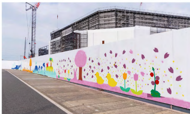
仮囲いスプレーアート
