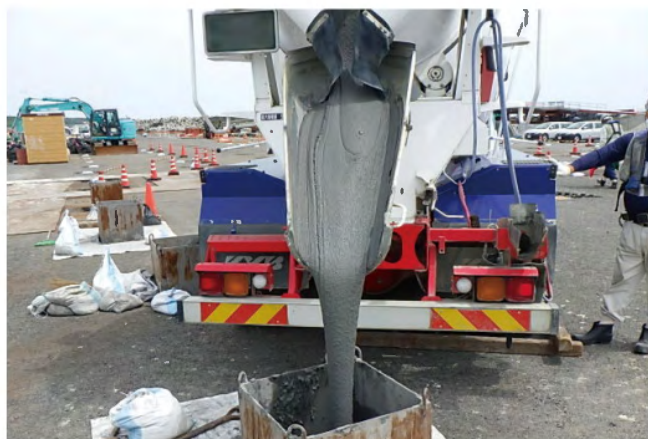
内部充填材 施工
