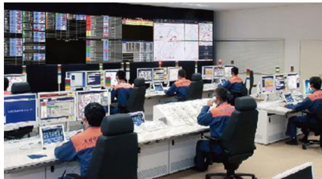
高機能消防指令センター
