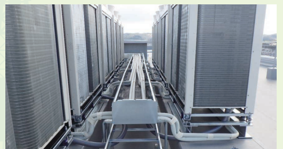
空調屋外機据付・配管作業
