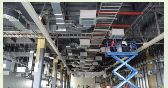
クリーンルーム空調室内機高所吊込み配管作業
