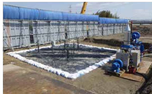
VOC(揮発性有機化合物)対策としての熱脱着土壌浄化(試験施工)(三重県桑名市)
