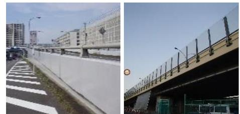
コンクリート構造物の剥落を抑制し長寿命化を図れます。環境配慮型塗料を使用した工期短縮型工法のため従来工法に比べ、VOC(揮発性有機化合物)を約80%削減できます。
