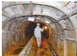
花輪鉱山 坑道点検の様子
