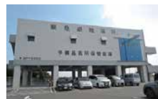
高所保管倉庫（堺製油所）
