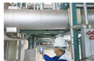
騒音測定の様子
