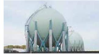
球形タンクのブレース（筋交い）補強
