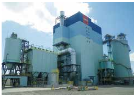
室蘭バイオマス発電所
