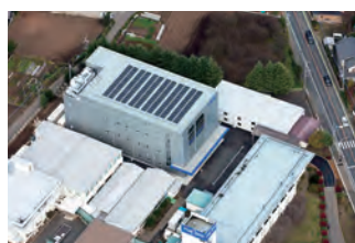
医療関連機器生産棟
