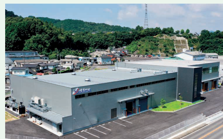
新本社工場 全景
