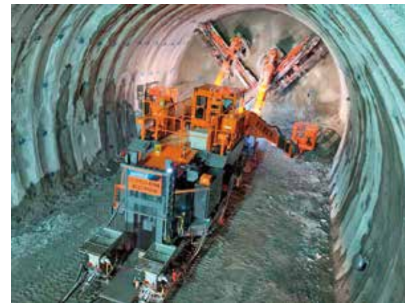
ロックボルト施工の完全機械化（「ロックボルタ」使用） 東海北陸自動車道 真木トンネル工事（富山県南砺市）
