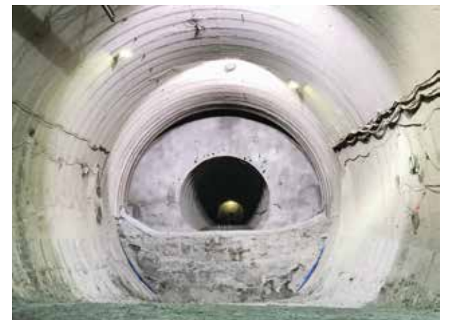
中央導坑先進工法における本坑の断面閉合状況 一般国道40号音威子府村音中トンネル掘削工事（北海道中川郡音威子府村・中川町）
