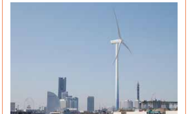
横浜市風力発電所 (ハマウィング)
