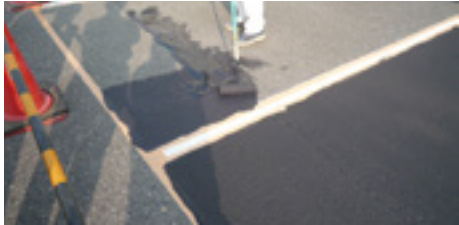
黒色遮熱塗料施工風景
