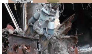
■圧碎機 ビル解体現場などでコンクリートの破砕や鉄骨・鉄筋の切断に使用されています。
