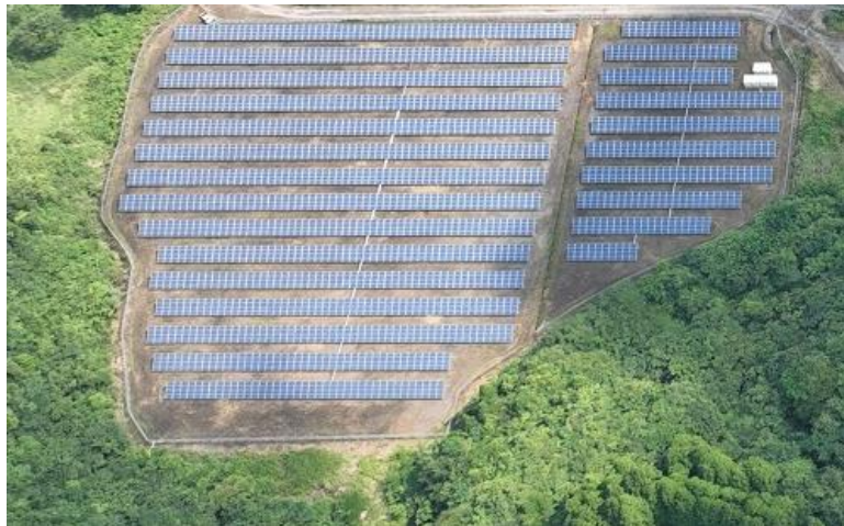
（TESS 宮崎高城ソーラー第三発電所）
