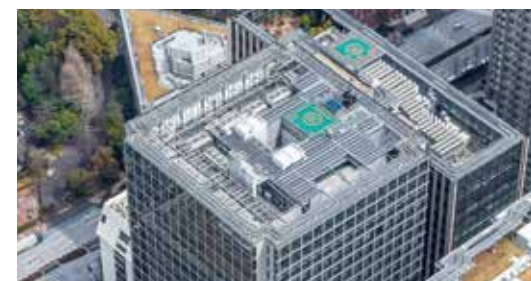
飯野ビルディング屋上の太陽光発電設備
