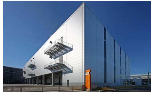
2 ロジスクエア八潮 2014 年 1 月竣工
