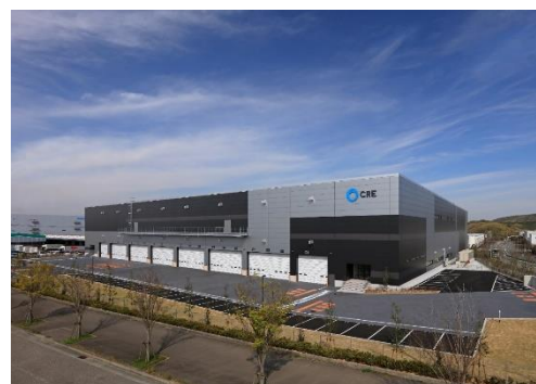
16 ロジスクエア神戸西 2020 年 4 月竣工
