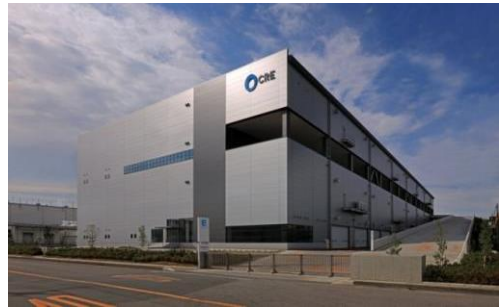
4 ロジスクエア久喜 2016 年 6 月竣工
