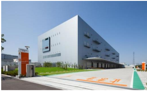
1 ロジスクエア草加 2013 年 6 月竣工
