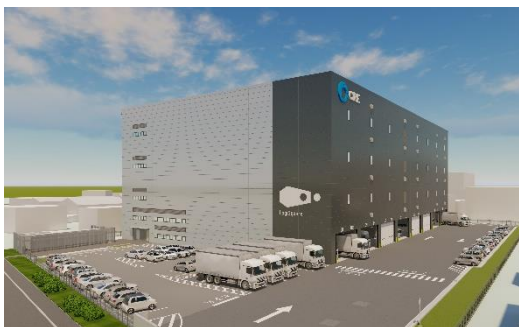
24 ロジスクエア厚木 I 2023 年 3 月竣工予定
