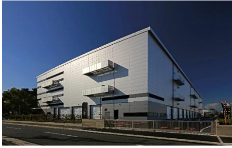
21 ロジスクエア伊丹 2022 年 11 月竣工
