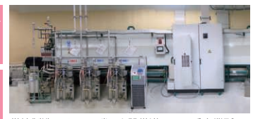
巻線製造ラインへの省エネ設備導入 三重事業所
