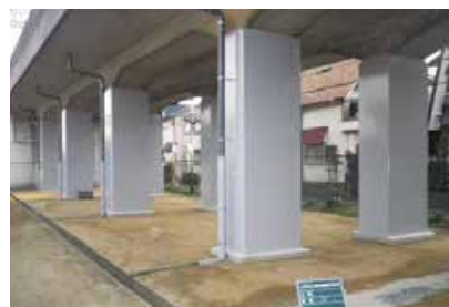
耐震補強工事
