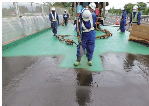
HQハイブレン工法（高性能床版防水工法）
