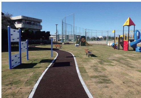
アスウッド工法（木材チップ舗装）
