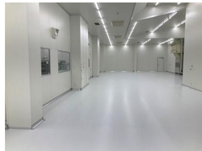
技術棟: クリーンルーム
