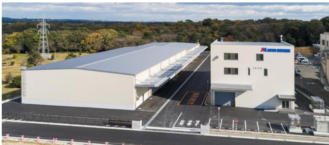
テクニカルサポートセンター（倉庫棟:左と技術棟:右）
