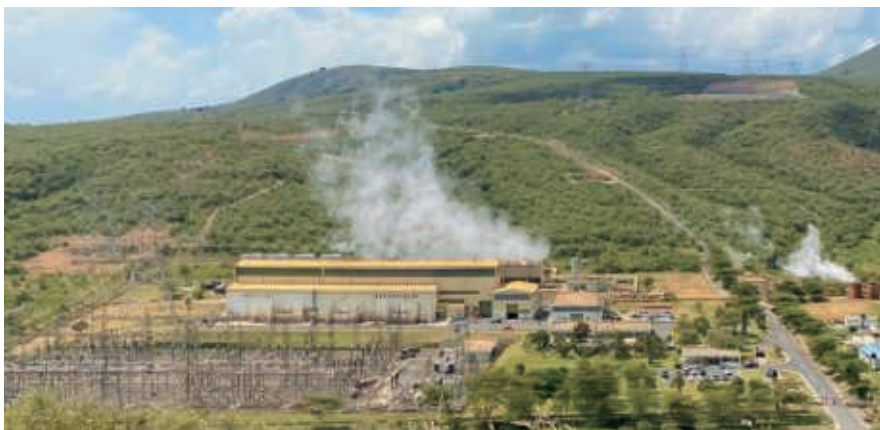
オルカリア地熱発電所 II
