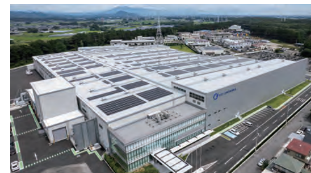
栃木県の段ボール工場太陽光パネル(2023年9月末完成予定)
