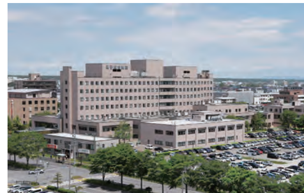
王子総合病院外観
