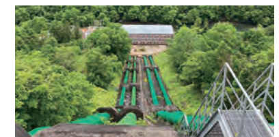
千歳第一水力発電所
