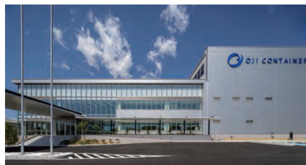
栃木県の段ボール一貫工場(2023年2月営業運転開始)
