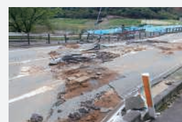
熊本地震による旧堤体の亀裂
